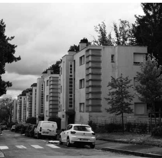
Immeuble avec façades de Cheusse
