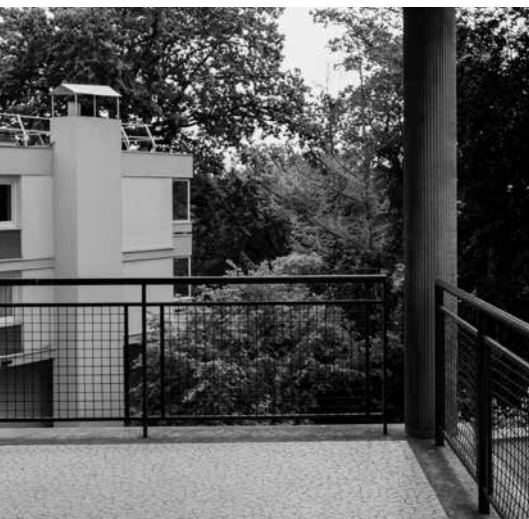
Espace terrassé collectif
