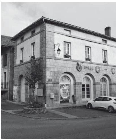
Bâtiment de l'ancienne Mairie du bourg de Latronquière.
